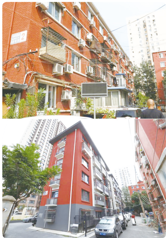
▲拼版照片：上图为改造前的北京市丰台区马家堡路68号院2号楼（资料照片）；下图为2026年7月14日拍摄的改造后的马家堡路68号院2号楼（张晨霖/摄）。北京市丰台区马家堡路68号院2号楼建于1977年，2023年该楼危旧楼房改建项目启动，这是北京市首个“原拆原建+平房上楼”的危旧楼改造项目。
