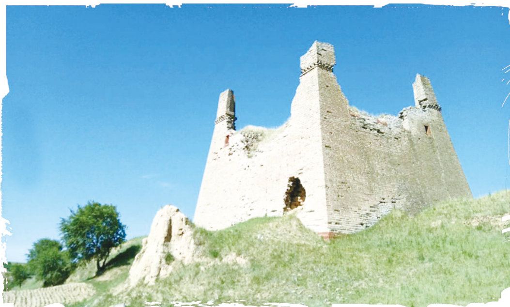
▲明长城板中沟段箭牌楼
